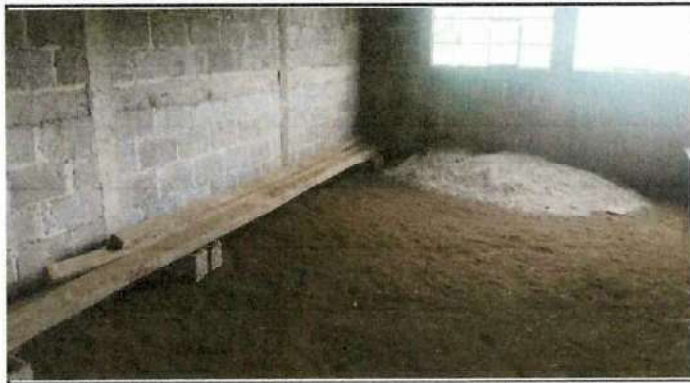
sustitucion de piso del aula 1 de tierra por piso formal de concreto.
