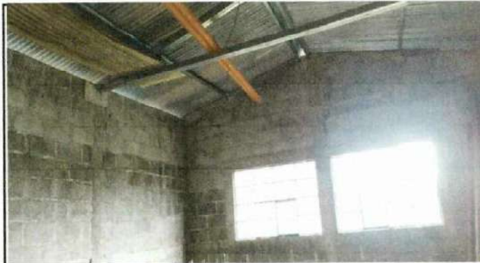
aplicación de repello en algunas aulas del centro educativo.
