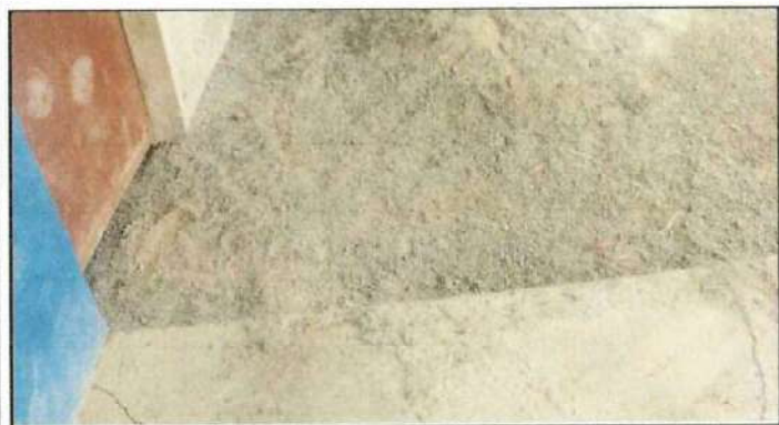
PISO DE AULA 2 Y CORREDOR CON PISO DE TIERRA. Mejoramiento de piso (piso de concreto)
