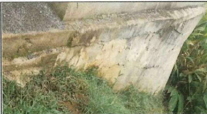
mejoramiento del muro perimetral del establecimiento.
