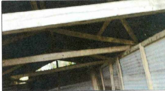
Sustitucion de Vigas de Madera por costaneras.
