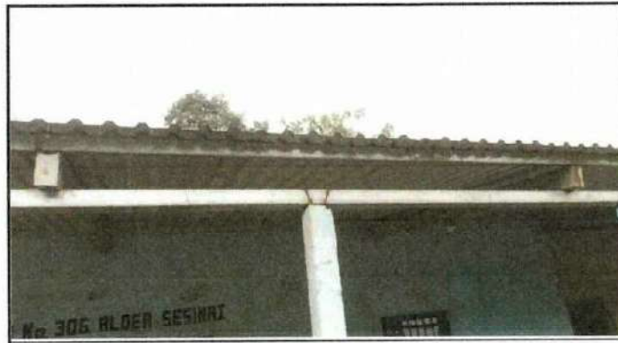
sustitucion de canales en mal estado
