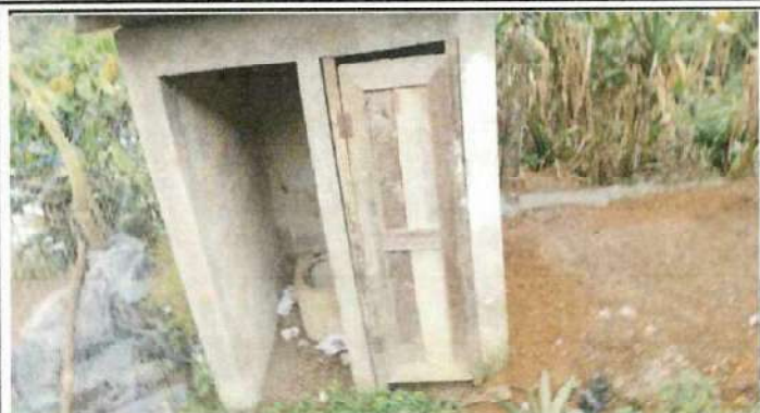
sustitucion de letrinas de concreto por letrinas de plastico
