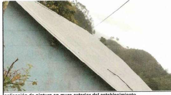
aplicación de pintura en muro exterior del establecimiento.
