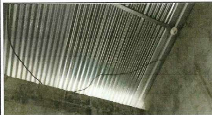
mejoramiento de la instalacion electrica del Centro Educativo.
