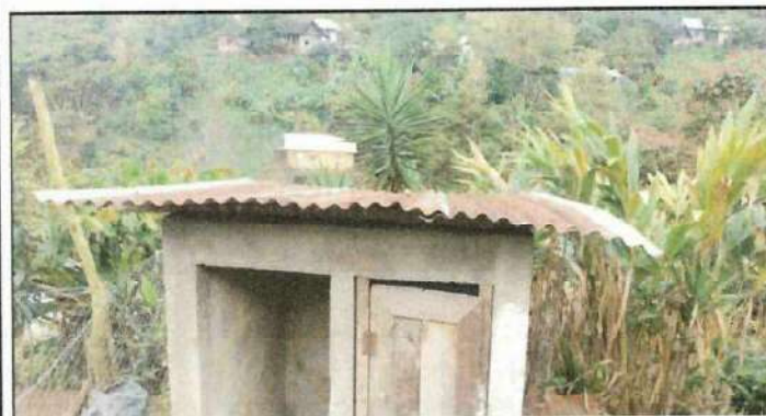
Sustitucion de techo del baño del establecimiento
