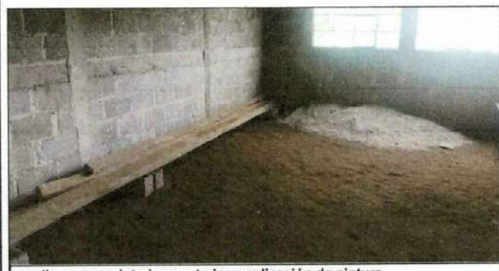
repello en muro interior y exterior y aplicación de pintura
