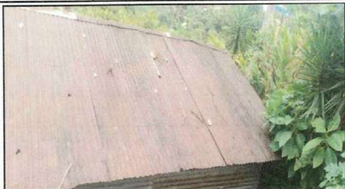
sustitucion de techo de cocina
